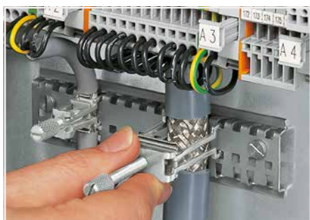
Clipsage d'un étrier de serrage
