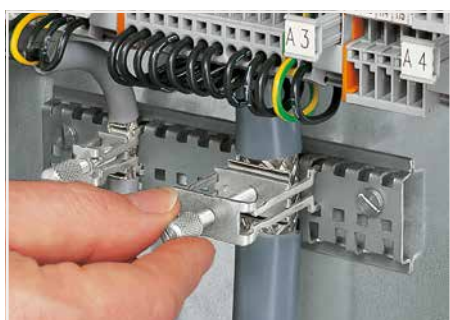
Serrage/desserrage d'étrier
