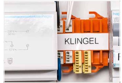
Exemple d'application dans une installation de sonnette – Fixation sur rail DIN 35
