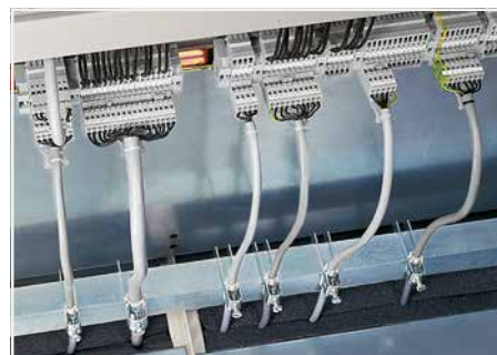
L'arrivée des câbles se trouvent dans la partie inférieure de l'armoire Dispositif de décharge de traction séparé, degré de protection IP 54, grâce à l'étanchéité des tôles de fond amovibles munies de joints caoutchouc mousse (fabriqués p. ex. par l'entreprise Rittal).
