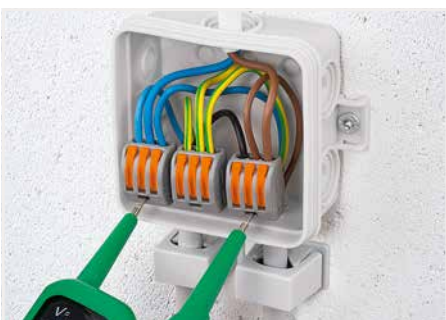
Test des bornes installées.
